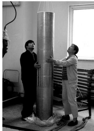
图 2 磁屏蔽筒的现场安装
